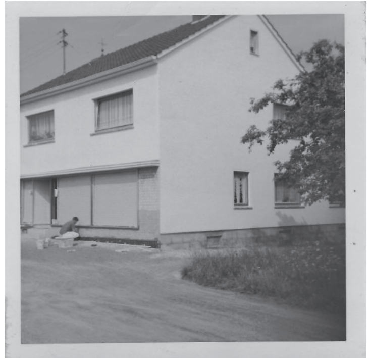
Neubau im Laubenweg kurz vor der Fertigstellung 1959.
